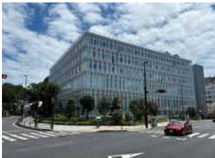
大宮区役所新庁舎
