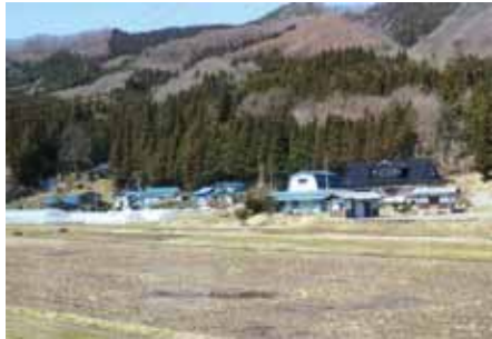
神話の里“遠野”の風景にそぐわない青いトタン屋根 (撮影：井上洋司)
