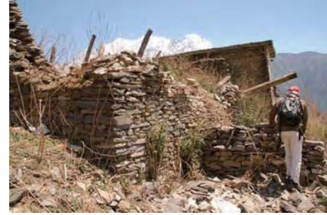
再生対象の廃屋調査
